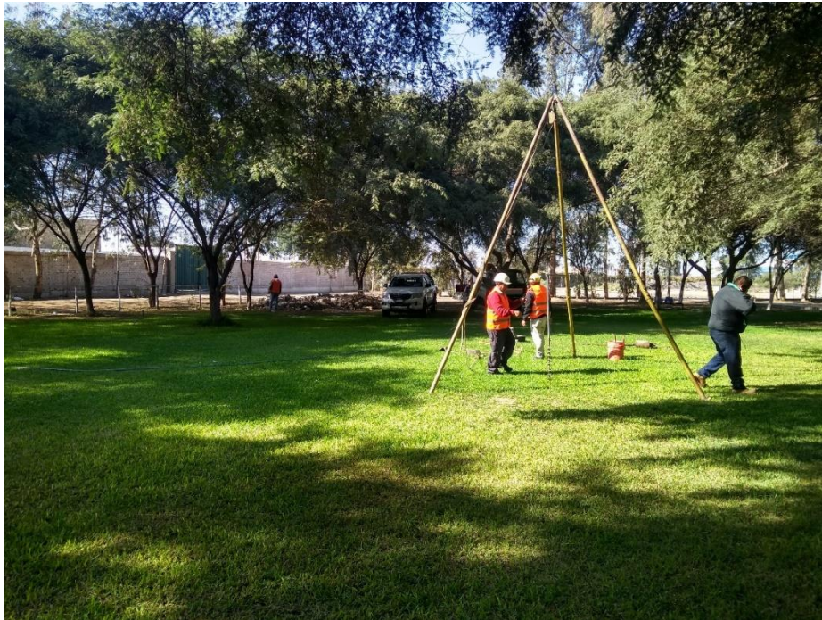
FOTO N° 06: TRABAJOS DE CAMPO PARA EL ESTUDIO DE SUELOS.
